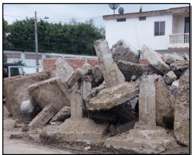
Figura 4. Columna corta en cimentaciones
