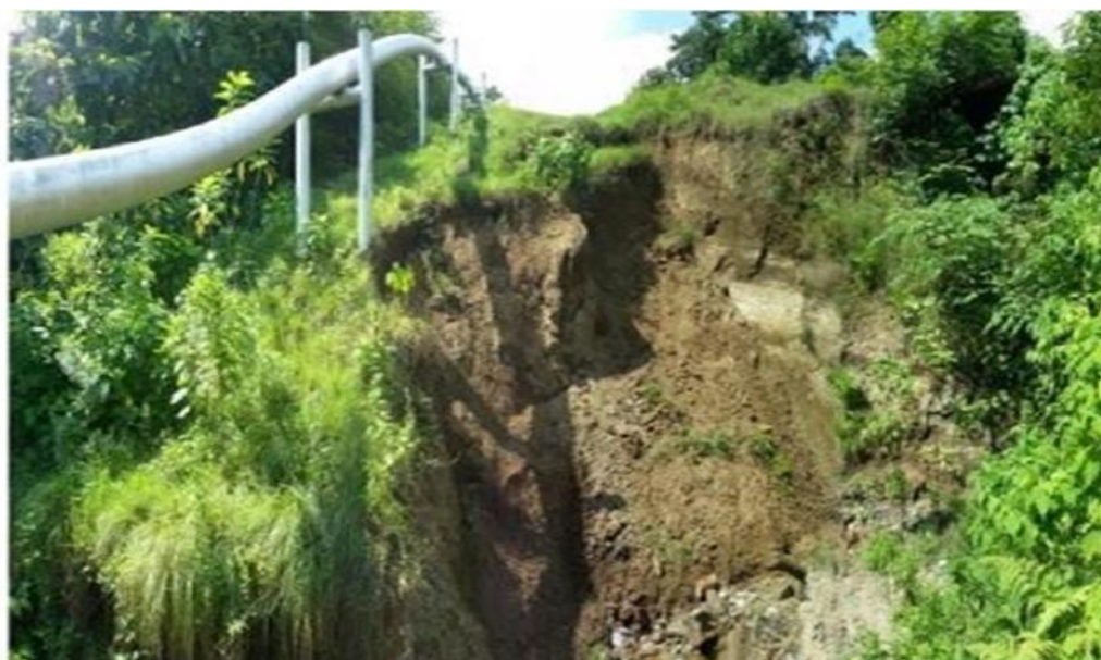
Foto 1. Vista panorámica de tubería que esta sobre el PK-6+920.
