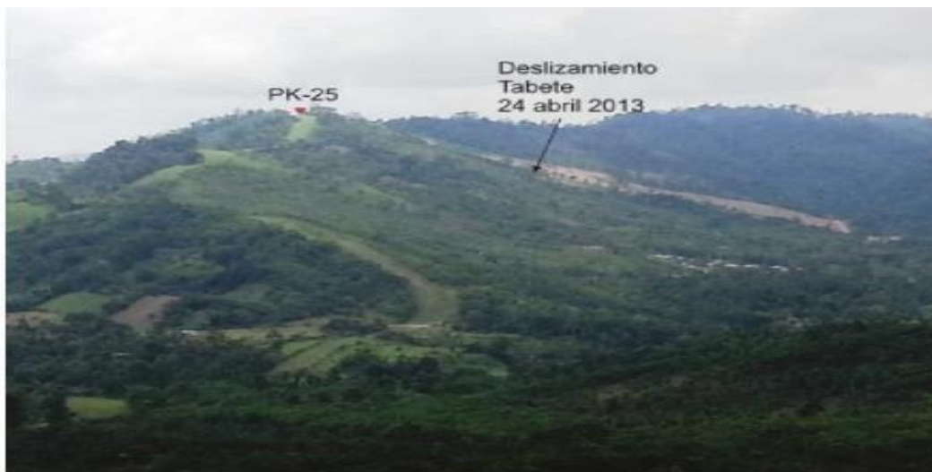
Foto 3. Vista panorámica de tubería que esta sobre el PK-25.
