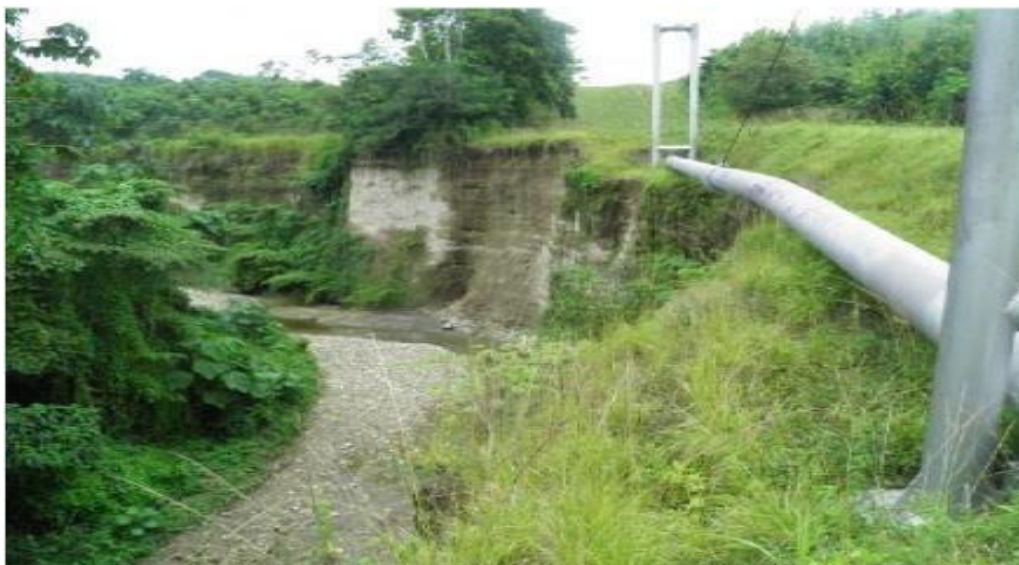
Foto 2. Vista panorámica de tubería que esta sobre el PK-12+700.
